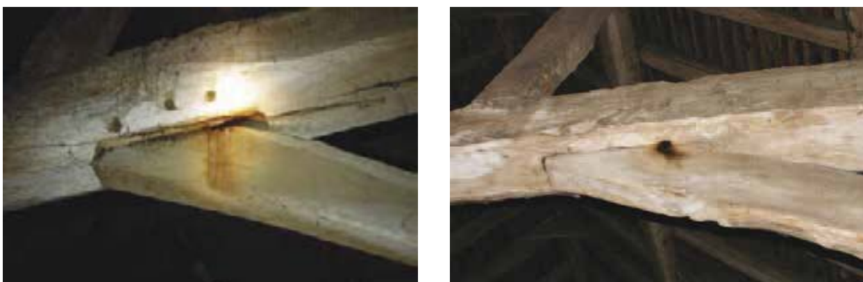
Figura 2.7 - Particolari delle congiunzioni di due travi in legno in un fienile col sistema tenone-mortasa, che forma una piccola cavità adatta al rifugio di chiroterri (da Briggs, 2004).
